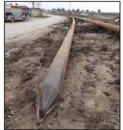
Çapı 400mm Uzunluk 300m Çelik Boru ile Nehir Geçiři
