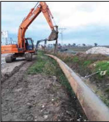
Çapı 500mm Uzunluk 230m Çelik Boru ile Otoban Geçiři
