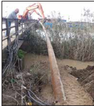
Çapı 400mm Uzunluk 150m Çelik Boru ile Karayolu Geçiři
