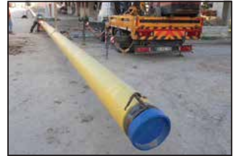
Çapı 300mm Uzunluk 180m Çelik Boru ile Doğalgaz Karayolu Geçiři
